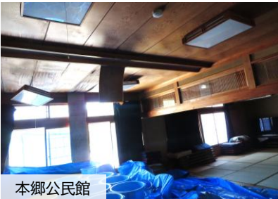
文化会館解体中(R8. 9)
