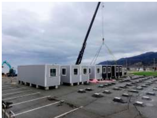
輪島市マリントウン 応急仮設住宅マリントウ ン第1団地 (キリコ会館多目的広場)建設現場
