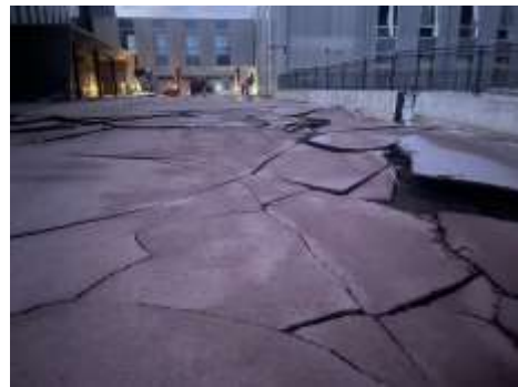
輪島中学校 地割れ
