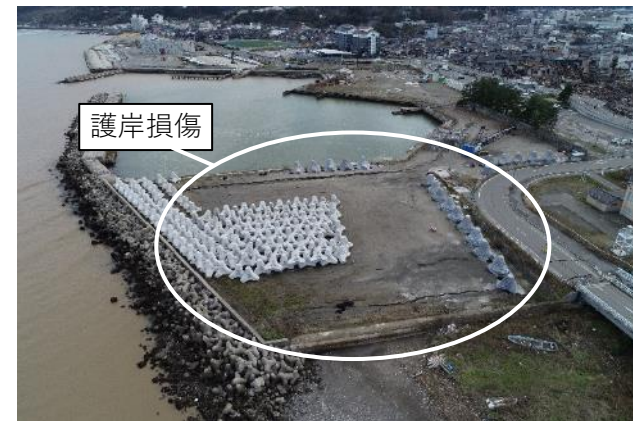
作業ヤード利用状況 (令和6年1月4日撮影)
