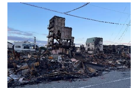
賑わい拠点の被災状況（朝市通り焼失）
