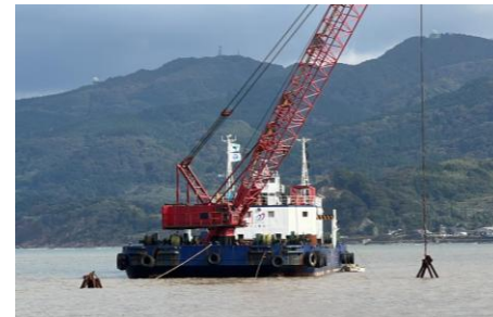
起重機船 (弘武) による緊急浚渫状況
