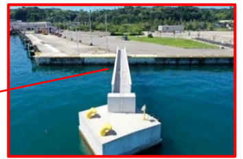
新潟県小木港(ドルフィン事例)
