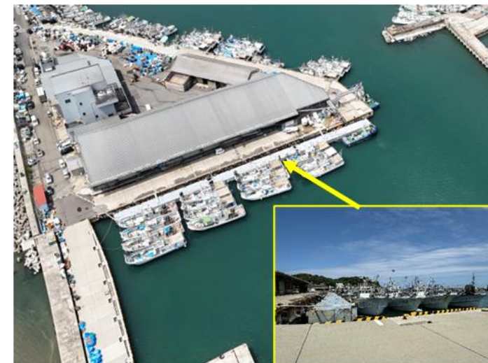
物揚場の高さに高さ合わせた応急対策 (仮栈橋設置)
