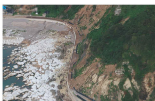
幹線道路の通行止め
