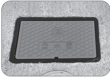
▲水道メーターボックス
