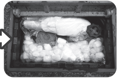
▲発泡スチロールなどで隙間を埋める
