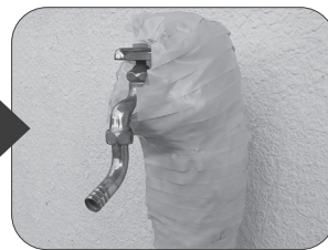
③ビニールテープでの補強
