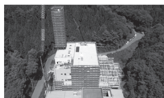
門前町原地内での建設工事の状況 (7月末現在)
