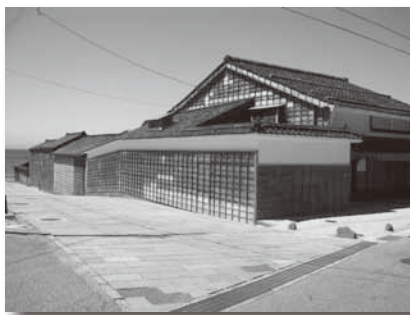
写真上: 震災により被害を受け応急処置が施された様子 (H19撮影) 写真下: 復元が完了し、公開の日を待つだけとなった様子 (H23撮影)
