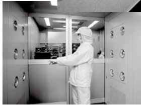
見学者案内通路(上)・入室時のエアシャワー(下)
