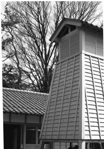
高さ 6,7m の冷却塔、この中を 61 度の源泉が流れ落ちて適温になります
