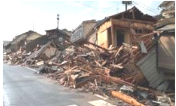
沿道建築物の倒壊による道路閉塞
