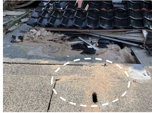
液状化の発生を示唆する噴砂 〔門前町道下〕
