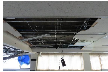
天井の被害状況（令和6年能登半島地震〔輪島市内〕）
