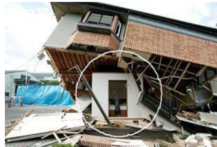
耐震シェルターの例
