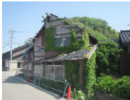
危険な空き家
