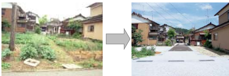
行き止まり道路の改善〔七尾市〕
