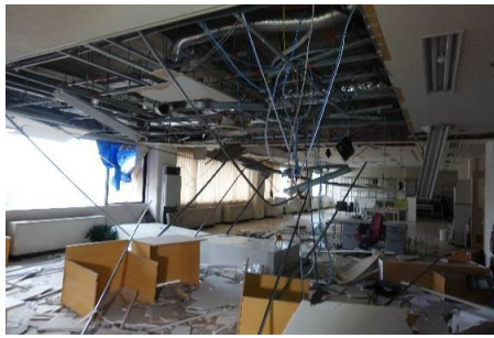
天井の被害状況（令和6年能登半島地震〔輪島市内〕）
