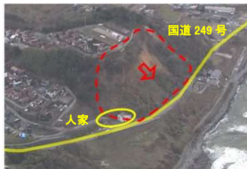
令和 6 年能登半島地震による地すべり発生状況〔輪島市大野町〕
