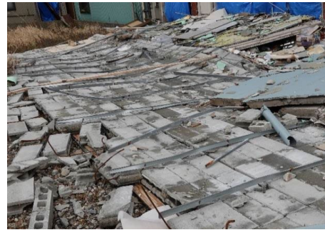
ブロック塀の広範囲での倒壊（令和6年能登半島地震〔輪島市内〕）
