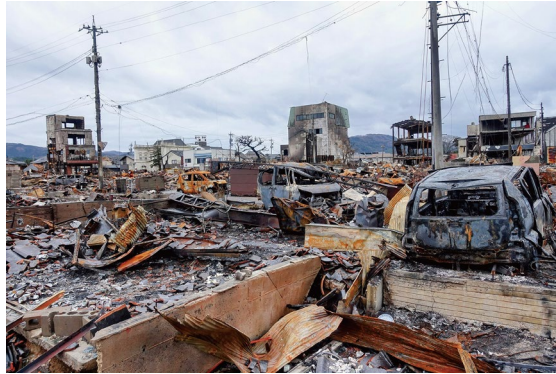
令和6年能登半島地震における市街地の火災状況
