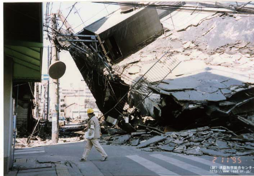
沿道建築物の倒壊による道路閉塞例（阪神・淡路大震災（H7））
