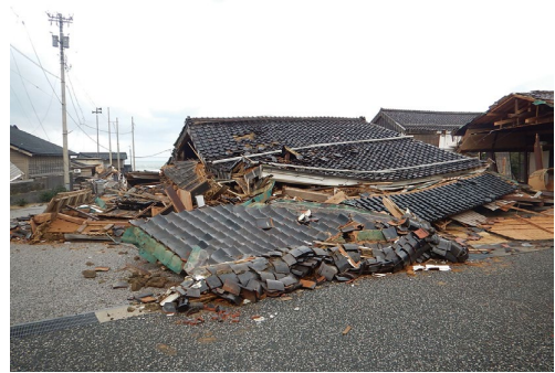
旧角海家の倒壊
