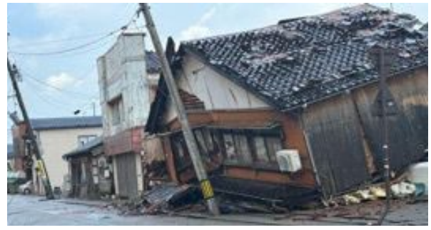
倒壊した木造建築物〔河井町〕
