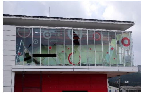
ガラスの被害状況（令和6年能登半島地震〔輪島市内〕）
