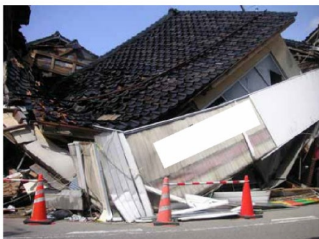
住家の被害状況〔門前町〕
