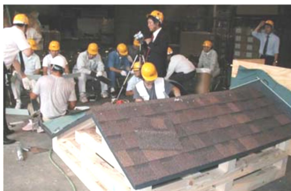
模型を利用した住宅耐震化の技術講習の様子
