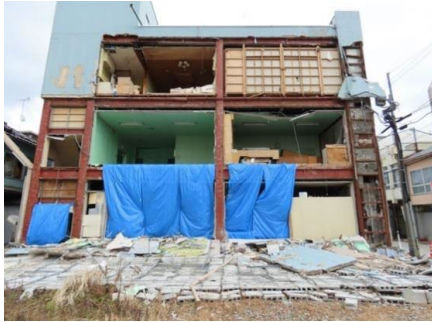
ブロック塀の広範囲での倒壊（令和6年能登半島地震〔輪島市内〕）
