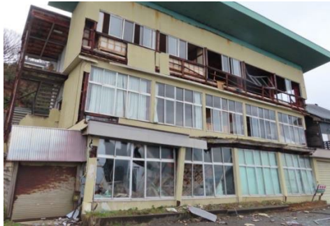
ガラスの被害状況（令和6年能登半島地震〔輪島市内〕）
