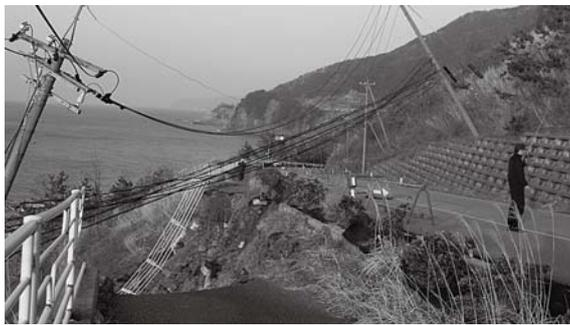
国道 249 号が崩壊、電柱も大きく傾いた
