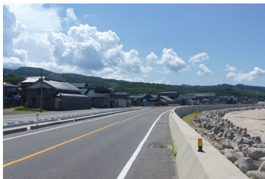
国道249号黒島道路の整備
