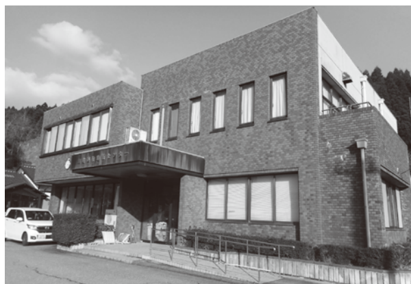
改修工事を行う三井出張所
