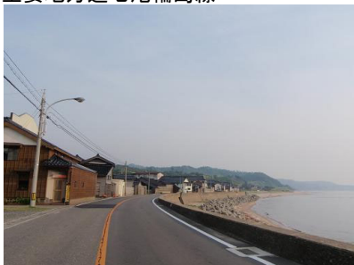
国道 249 号(海岸沿い) *
