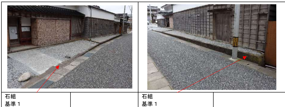
写真-49 石垣（東、北面）部位の設定
