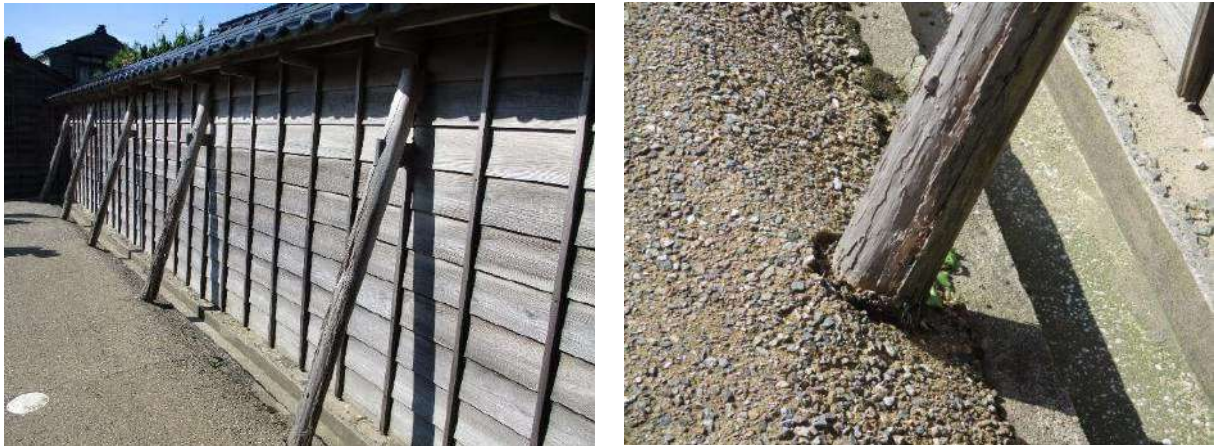
写真-63 添え柱の現状
