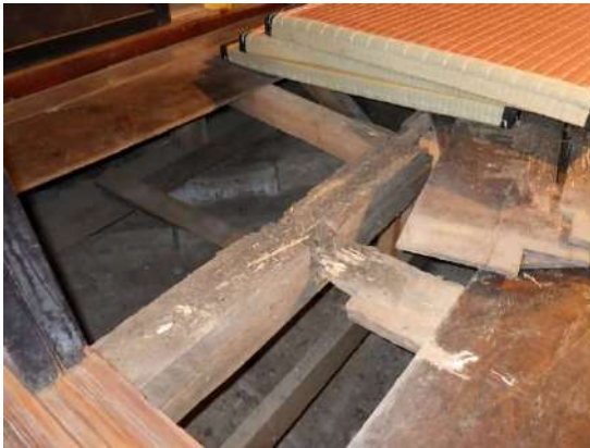
写真-50 床板・根太の損傷(左:修理前・右:修理後)
