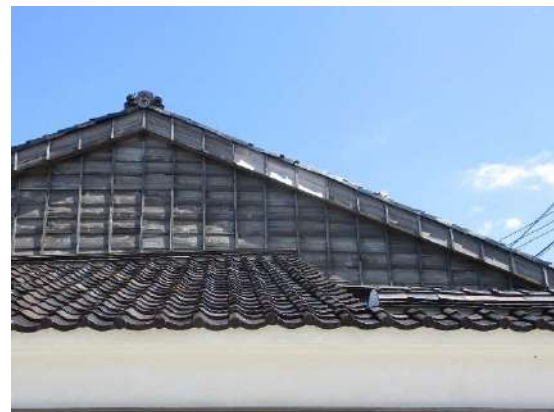
写真-53 下見板等の欠損 (左: 修理前・右: 修理後)
