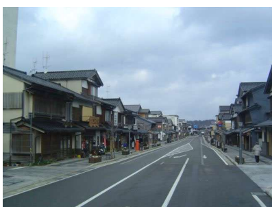
主要地方道七尾輪島線 *
