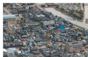
市街地への土砂流入
