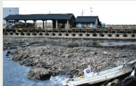
海底隆起・漁港機能の喪失
