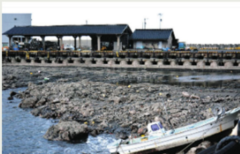
海底隆起・漁港機能の喪失
