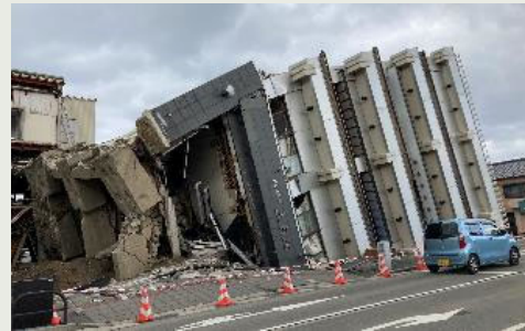
高層ビルの倒壊
