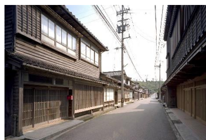
輪島市黒島地区 伝統的建造物群保存地区
